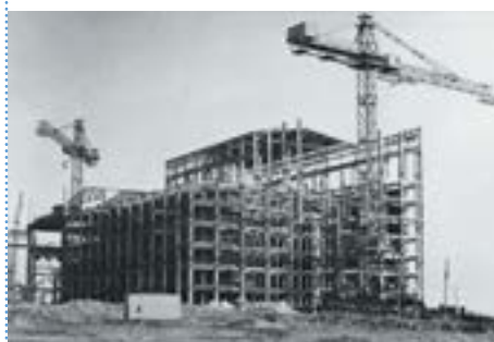
Строительство обогатительной фабрики № 12
