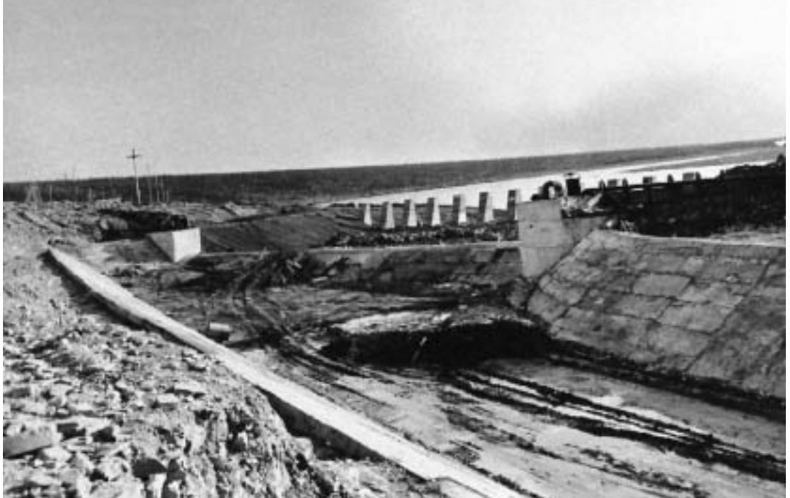
Обустройство плотины ГЭС-1
