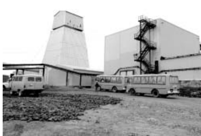
Строится подземный рудник "Удачный"
